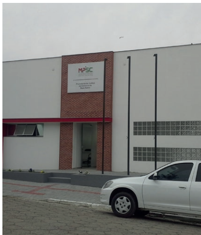
Reforma da Nova Sede em Bom Retiro
