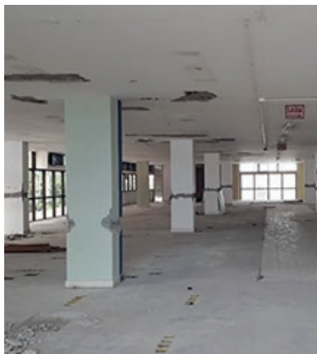
Retirada de divisórias 7º Pavimento do Ed. Casa do Barão
