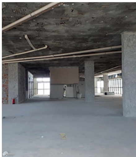
Demolição de paredes e banheiros no 10º Pavimento do Ed. Casa do Barão
