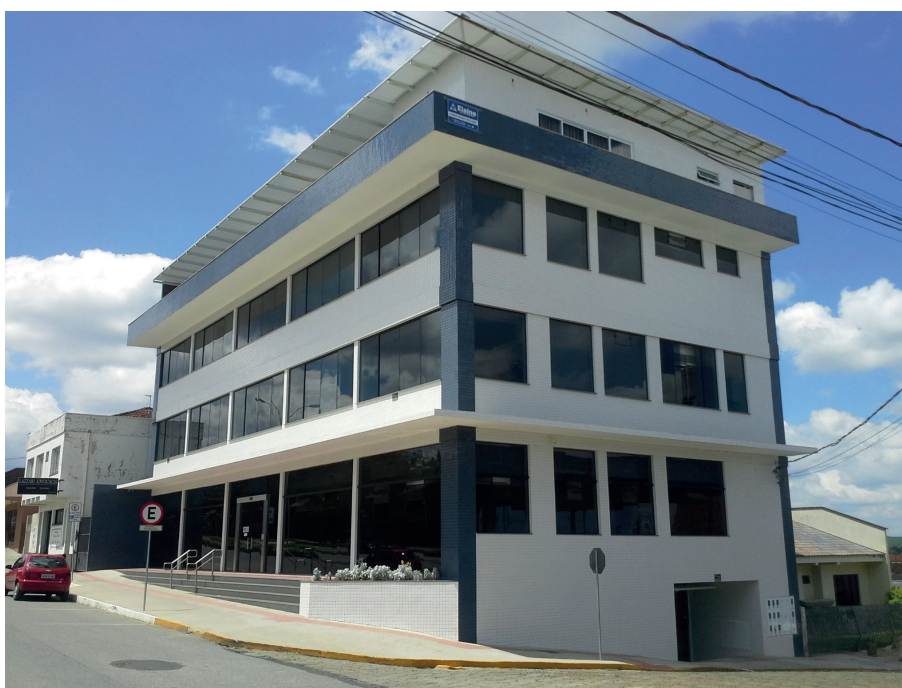
Edifício do MPSC em Mafra
