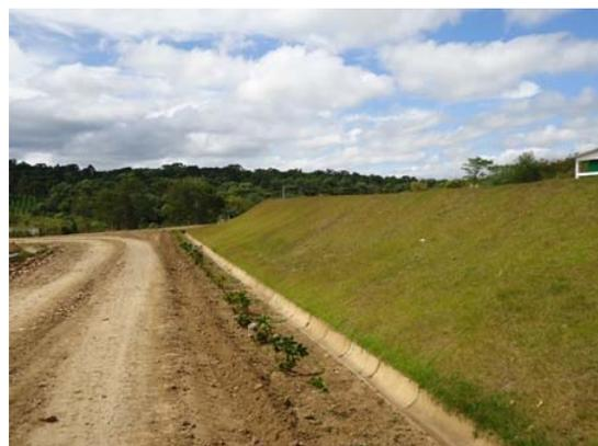
Figura 19 – Drenagem de águas pluviais
