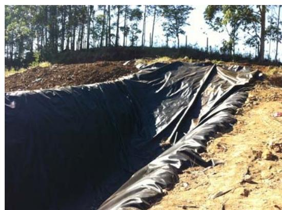
**Figura 154 – Vala de disposição tipo trincheira**
