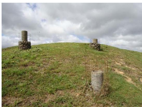
Figura 84 – Drenos de gases
