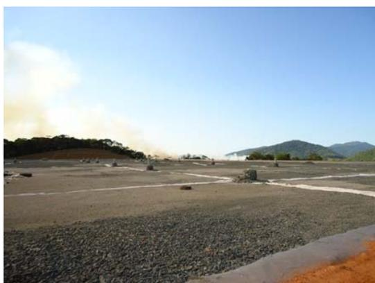
Figura 6 – Drenos de gases
