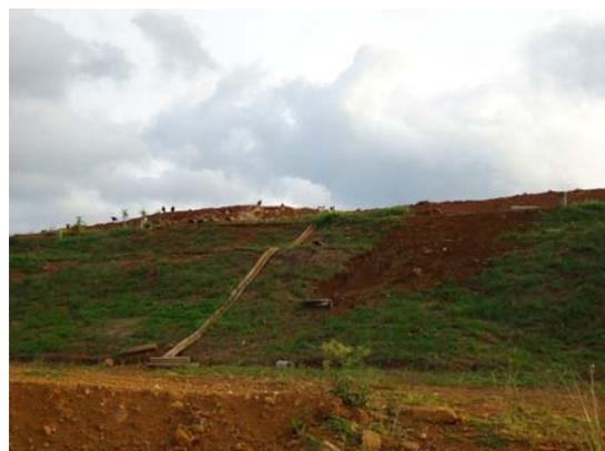
Figura 31 – Dreno de água pluvial
