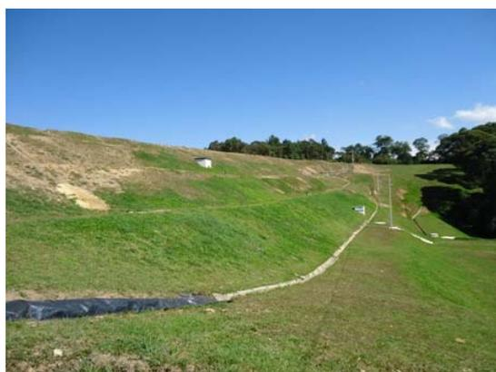
Figura 214 – Vista dos taludes e drenos de águas pluviais
