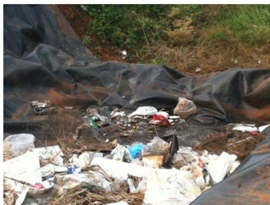
Figura 164 – Detalhe da manta geotêxtil
