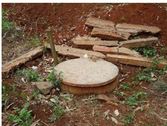
Figura 56 – Poço de controle do líquido percolado (chorume)
