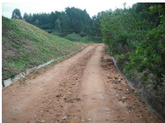
**Figura 128 – Acesso interno e drenos de águas pluviais**
