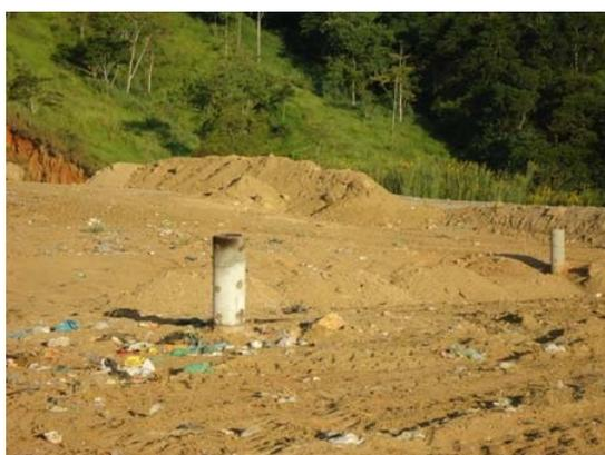
Figura 12 – Drenos de gases
