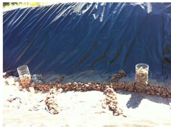
**Figura 156 – Detalhe dos drenos de condução dos gases e dos percolados (chorume)**
