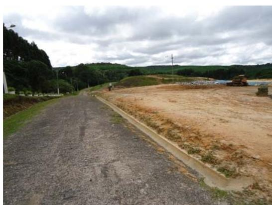
Figura 86 – Acesso interno e drenos de águas pluviais
