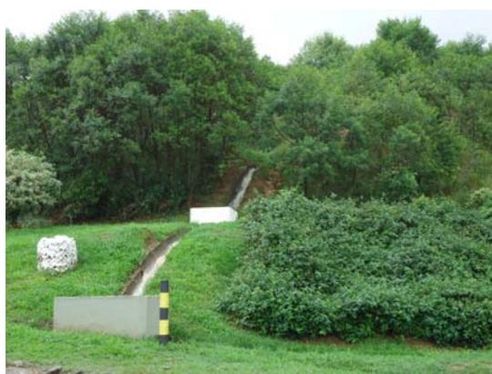
**Figura 97 – Drenos de águas pluviais**
