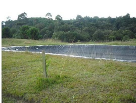
**Figura 111 – Tanque para armazenamento temporário de chorume**
