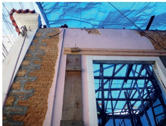
Figura 67 – Detalhe de consolidação de alvenarias. 2017.
