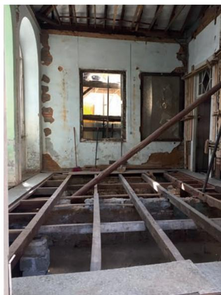
Figura 48 – Obras de recuperação do barroteamento na sala frontal. 2018.
