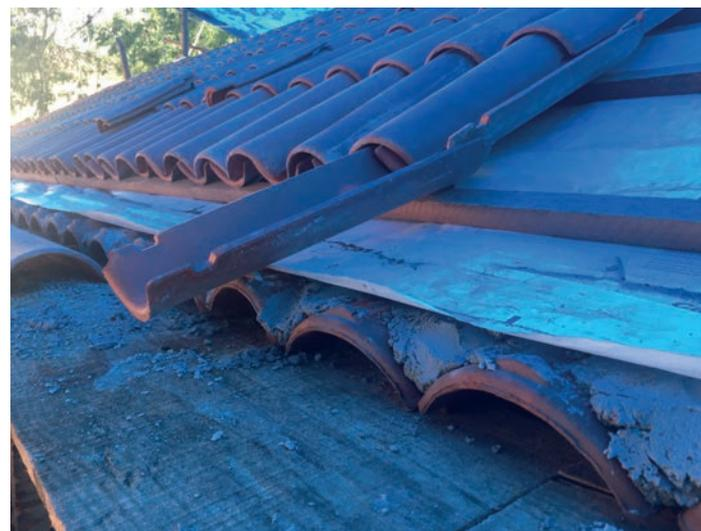
Figura 51 – Retelha em capa e canal. 2018.
