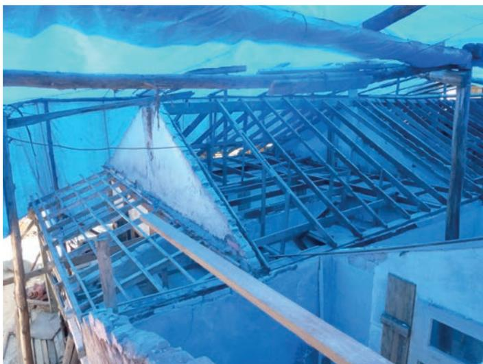
Figura 50 – Obras de recuperação do madeiramento do telhado. 2018.
