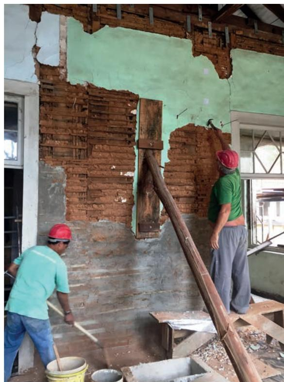
Figura 68 – Recuperação de emboço, reboco e taipa de mão de parede interna. 2017.
