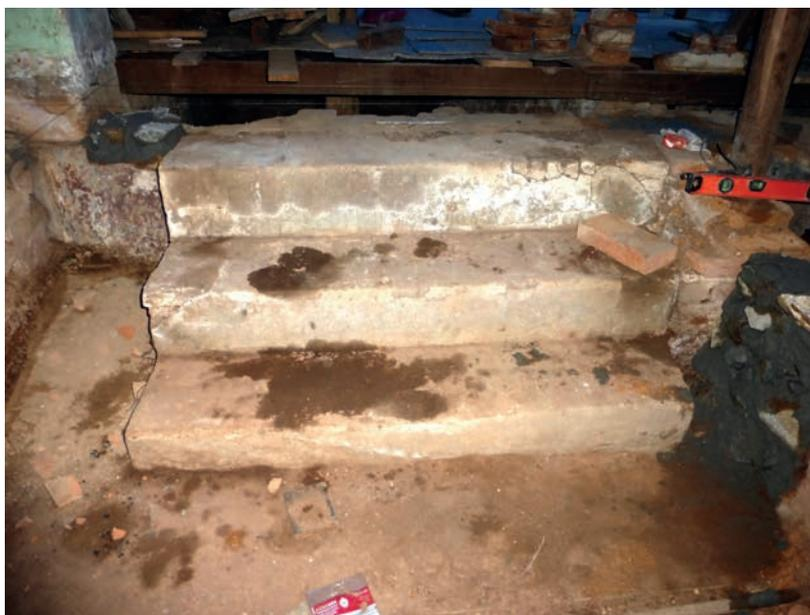
Figura 43 – Degraus descobertos abaixo do tabuado. Indicam final da primeira fase da construção do século XIX.
