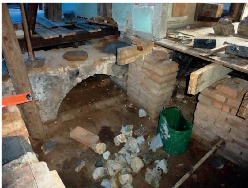
Figura 44 – Detalhe da abobadilha em tijolos maciços, argamassados com massa de barro, cal e areia, localizados abaixo do tabuado indicam solução de estrutura construtiva utilizada no século XIX.
