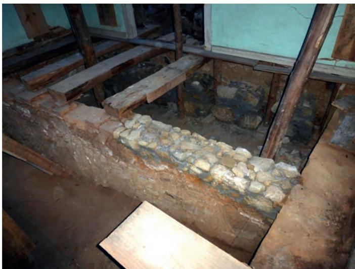
Figura 60 – Detalhe do topo das fundações originais. São baldrames em alvenaria de pedras argamassadas em barro, cal e areia. 2017/18.
