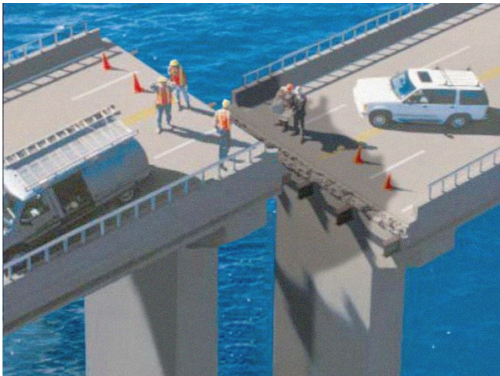
Imagem 5: Ilustração representando possíveis consequências de falhas de datum em etapas de projetos de engenharia. Fonte: Adaptado de Google Images - https://www.google.com/search?q=misaligned+bridge
