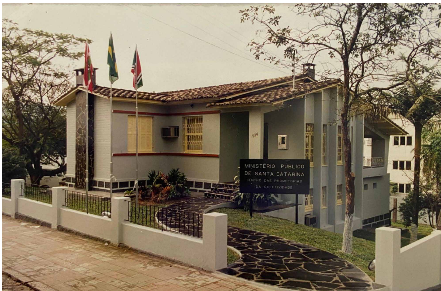
Figura 32: Centro das Promotorias da Coletividade de Criciúma.
