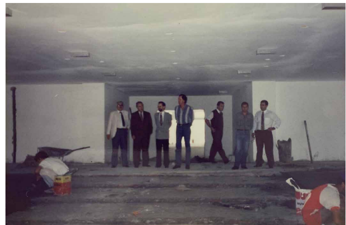
Figura 42: Vistoria do prédio em construção.
