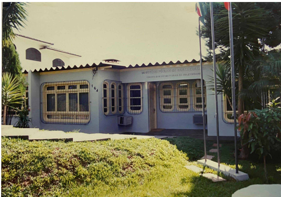
Figura 33: Centro das Promotorias da Coletividade de São Miguel do Oeste.
