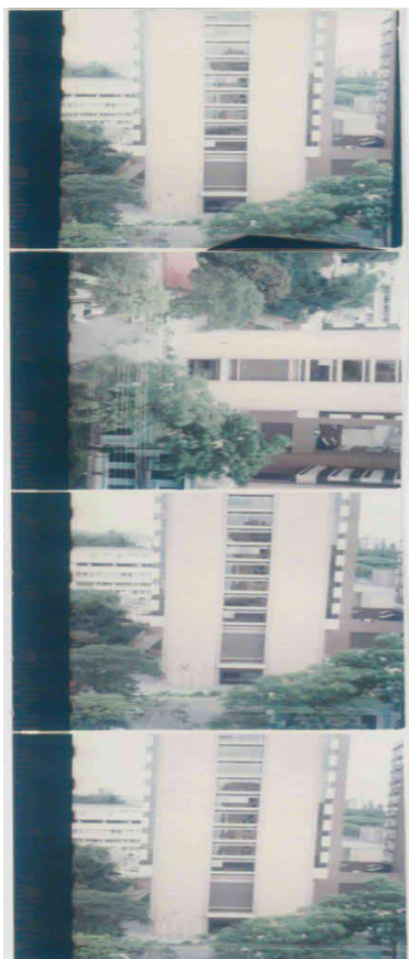
Figura 46: Estrutura do Centro Executivo Casa do Barão
