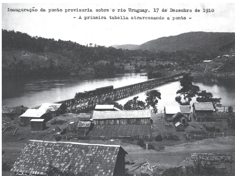
Inauguração da ponte sobre o rio Uruguai. Fonte: ABPF/PR.
