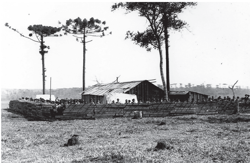
Fortificação em dormentes para proteger a Lumber, Três Barras.
